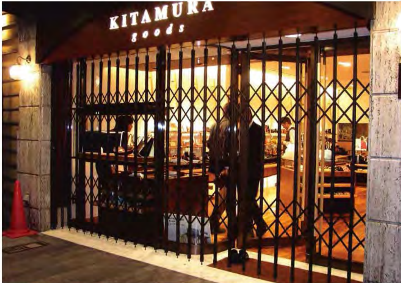
W5,000×H2,500 スチール製(指定色:ブロンズ) 両引き分け仕様(片引き、回転扉仕様) 下レールなし
