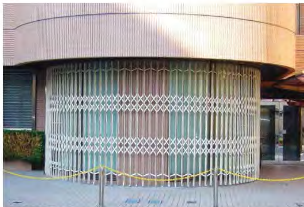
W9,000×H2,700 アルミ製(指定電解着色:ミルキーホワイト) 片引き仕様、全体R=2,500
