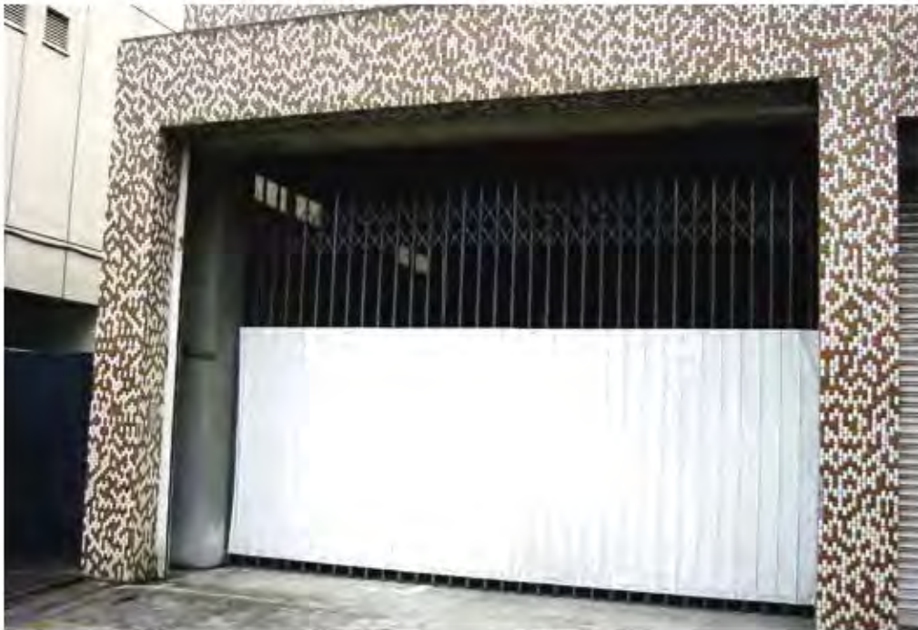
W5,000×H3,500 スチール製(標準色:グレー) 片引き仕様 目隠しセフティシート(ホワイト) H2,000
