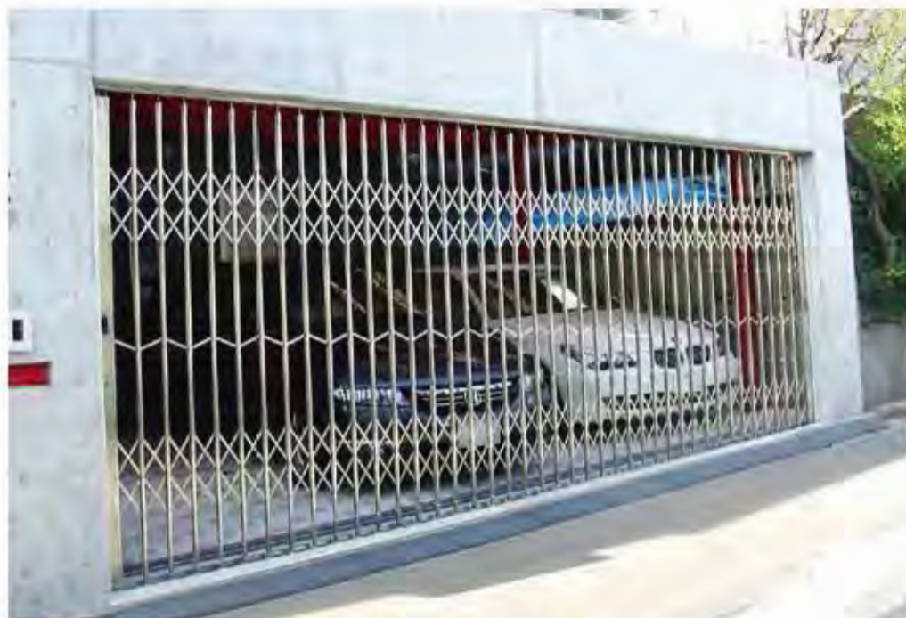
W5,000×H2,500 ステンレス製、片引き仕様、フリー型
