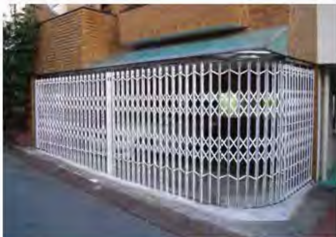
W8,000×H2,200 アルミ製(ミルキーホワイト) 両引き分け仕様、曲げR=900
