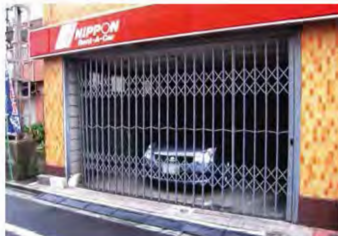
W3,800×H2,500 スチール製(標準色:グレー) 片引き仕様、曲げR=600
