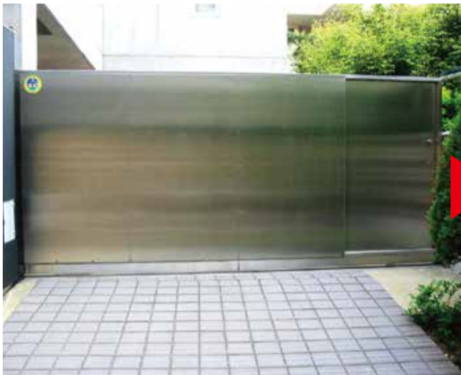
◀◀り戸付き W4,800×H1,800 ステンレス製、片引き、フラッシュパネルタイプ、※引き戸仕様
