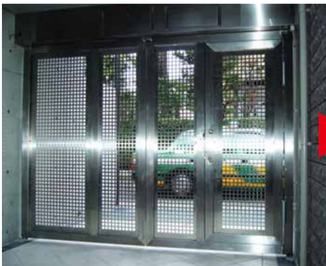
◀◀り戸付き W3,500×H2,500 ステンレス製、観音開き型、アルミパンチングパネルタイプ、◀◀り戸手動・電気錠付き、※開き戸仕様
