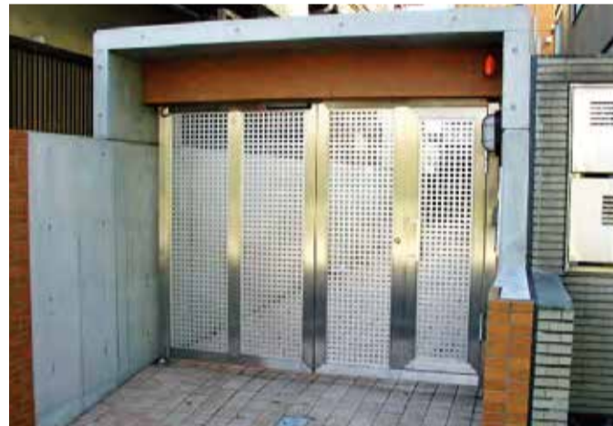
W3,300×H2,500 ステンレス製、観音開き仕様、くぐり戸付き、電気錠付き、アルミパンチングパネルタイプ
