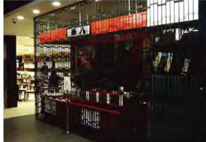
W6,000×H3,000 アルミ製パイプ(電解着色:ブラック)、片引き仕様、曲H R=600
