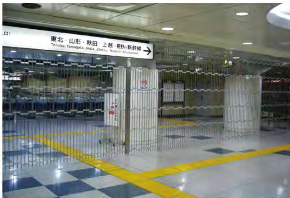
W18,000×H2,700 ステンレス製パイプ、片引き仕様、下レールなし、3連装
