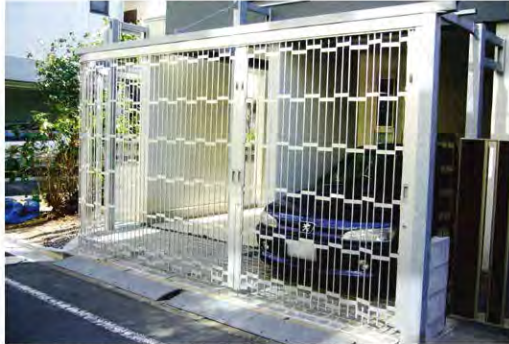
W7,100×H2,200 強化PC製パイプ、片引き仕様、下レールなし、2連装
