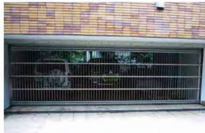
W8,200×H2,300 ステンレス製、片引き仕様、BOX型、ストレートタイプ
