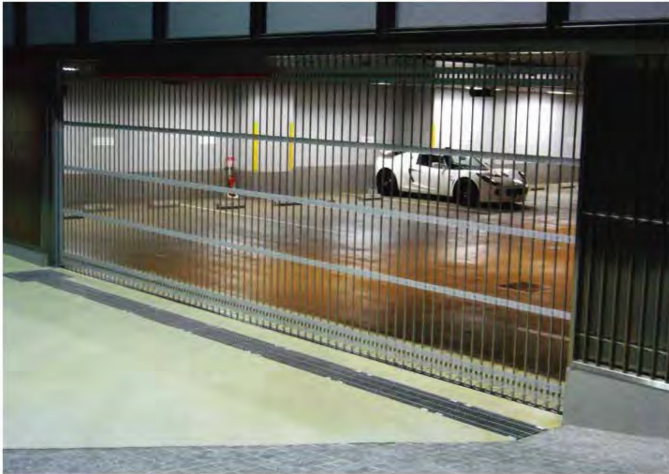
W6,200×H2,400 ステンレス製、片引き仕様、BOX型、ストレートタイプ
