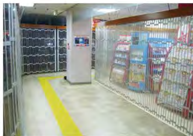
W8,000×H2,400 強化PC製パイプ、両引き仕様、下レールなし
