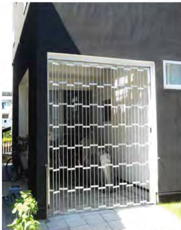
W2,600×H2,600 アルミ製パイプ、片引き仕様、下レールなし
